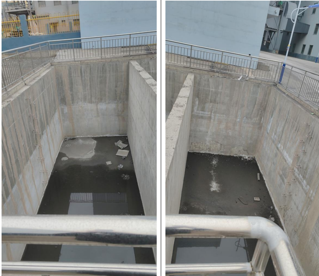
洗车废水沉淀池
