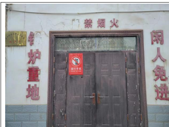
兰州财经大学东岗校区燃气锅炉房
