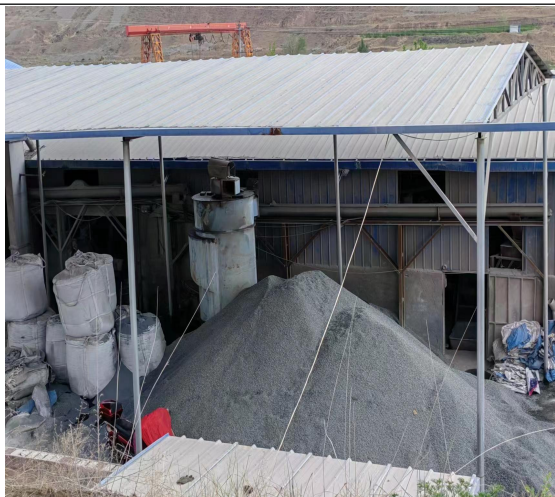
半封闭式原料堆场
