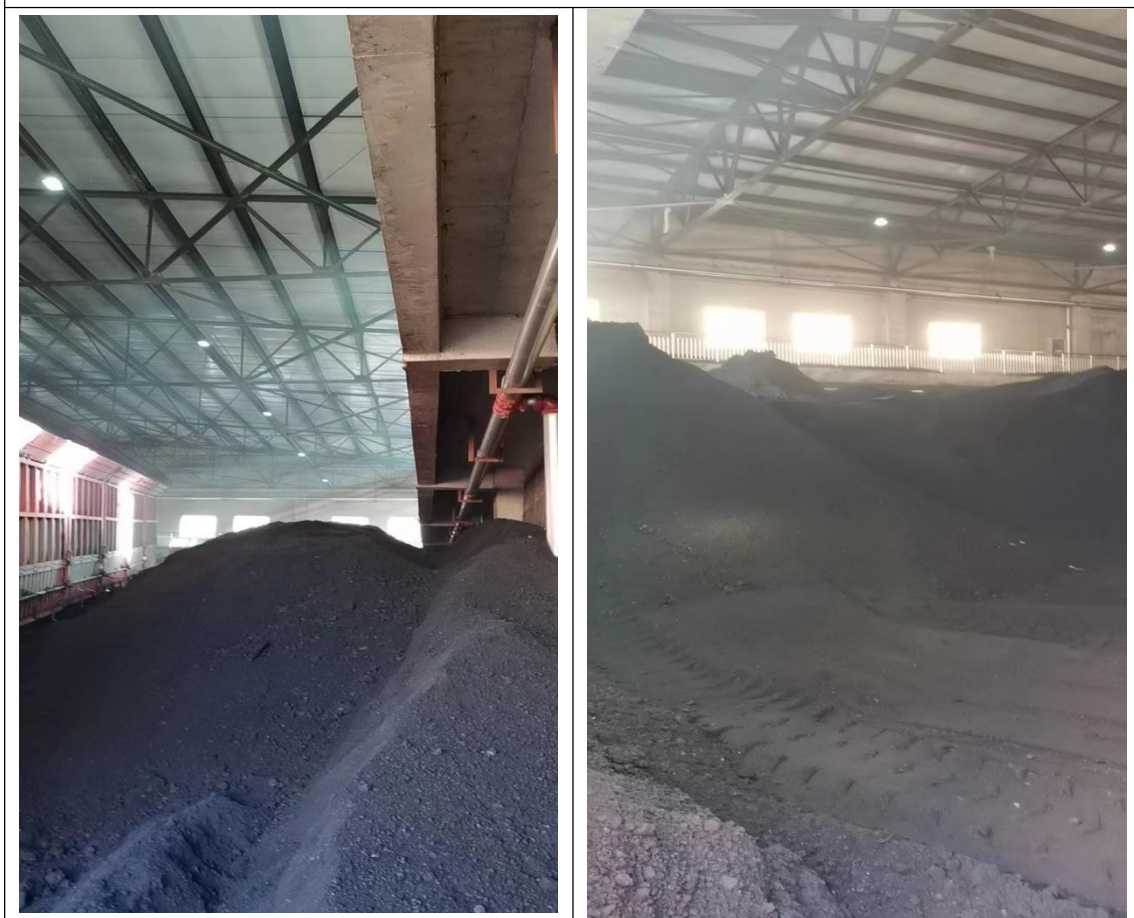
半封闭式煤库
