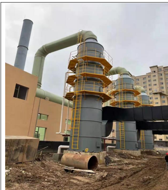
施工阶段脱硫塔
