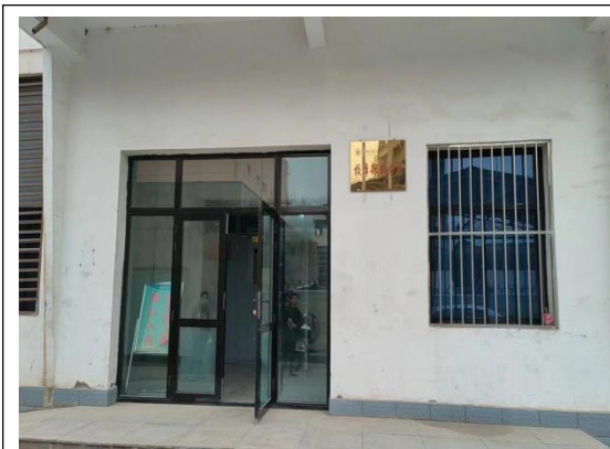
兰州交通大学燃煤锅炉改燃气锅炉房
